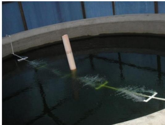
**Figura 05.** Sistema de aireación.
