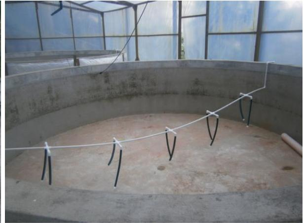
**Anexo 07 y 08.** Colocación de mangueras para sistema de aireación.
