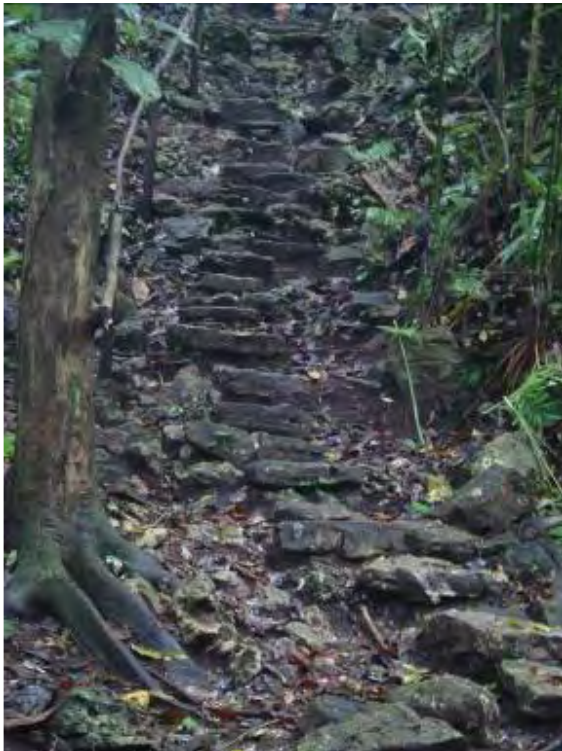
Fig. 66. Estado de deterioro acceso 7 entrada principal a la plaza Oeste.
