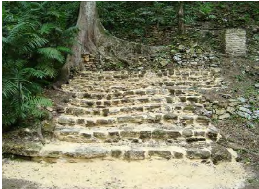
Fig. 47 Escalinata del palacio J-6 después del resane y consolidación
