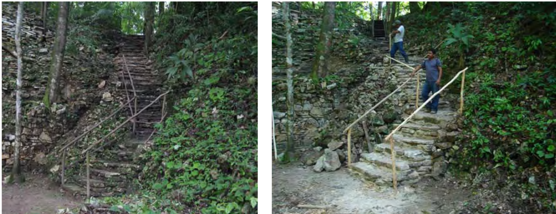
Fig. 58. Colocación del acceso 3, comunica del J-7 hacia el patio 2. Imagen derecha arriba se observa la escalinata de madera trabajos del 2008. Izquierda adaptación del tramo total 2009.
