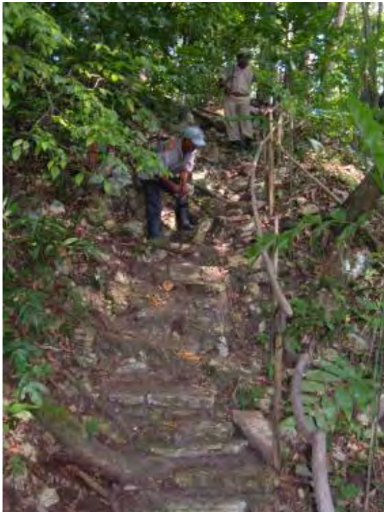
Fig. 60. Estado de deterioro del acceso 4, comunica el patio 2 con el patio 3.
