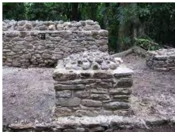
Fig. 31. Estado de deterioro y consolidación de la sección 1 del palacio J-2.
