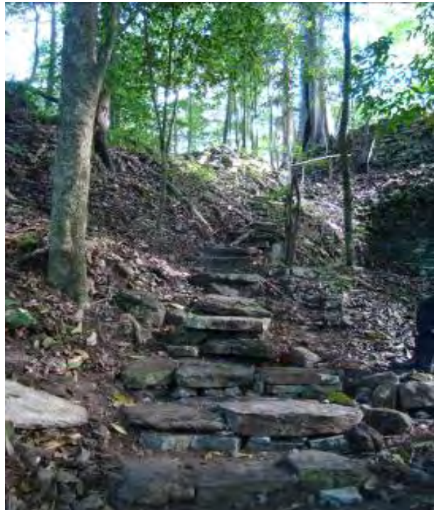
Fig. 62. Estado de deterioro del acceso 5, conduce hacia el templo J-28. Hasta junio 2009.
