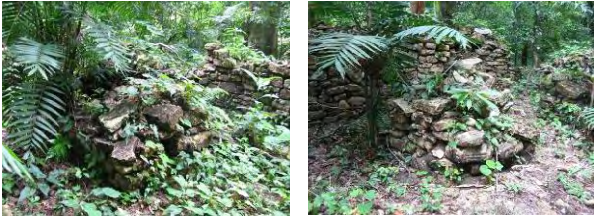
Fig. 30. Estado de deterioro de las columnas centrales de la fachada interior del palacio J-2. Secciones 1 y 2
