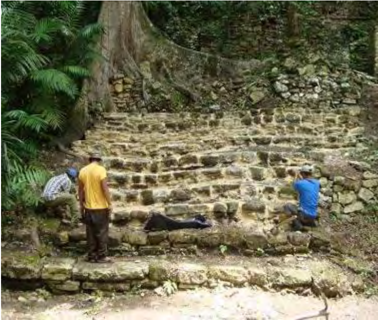
Fig. 46. Proceso de resane y consolidación de la escalinata del palacio J-6
