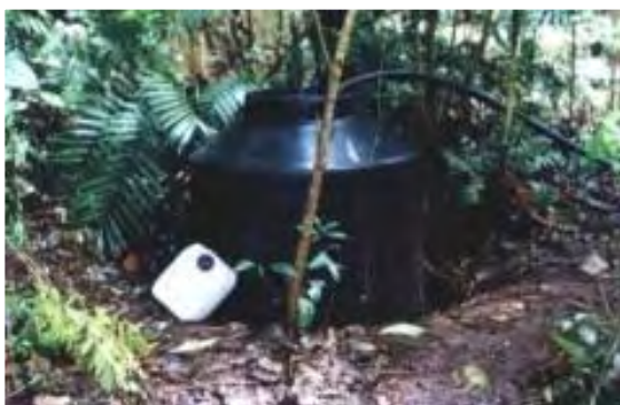
Fig. 27 Tinaco para captación de agua en la primera estación hacia la acrópolis.
