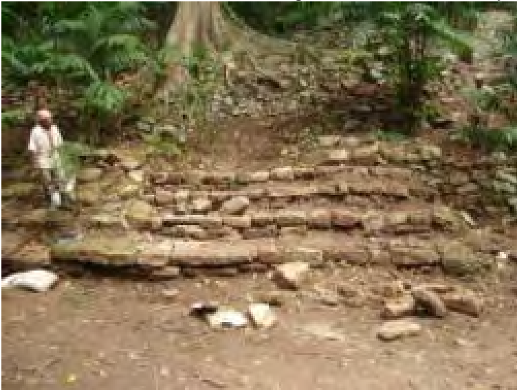
Fig. 44 Proceso de consolidación y recuperación de la escalinata dl palacio J-6.
