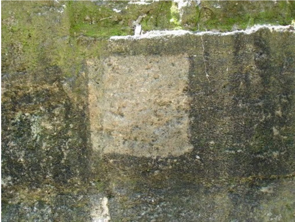
Figura 23. Aplicación de Tratamiento 2 (T-2), prueba 2008-MMV-013 Yaxha (Foto D. Aquino).
