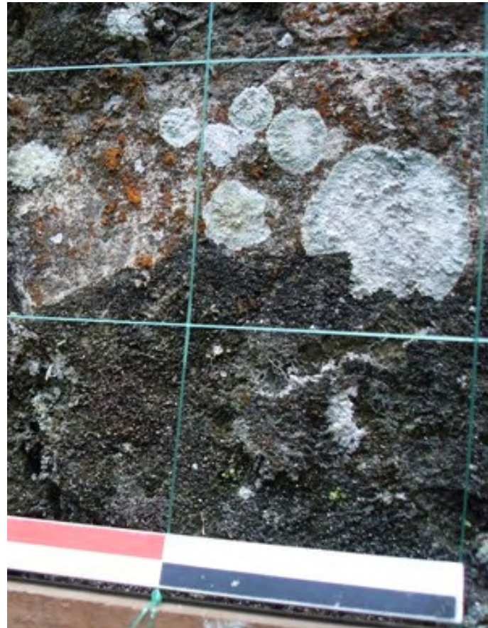
Figura 19. Crecimiento de Liquen crustáceo escamoso sobre bloque calizo, Edificio 216 Yaxha (Foto D. Aquino).
