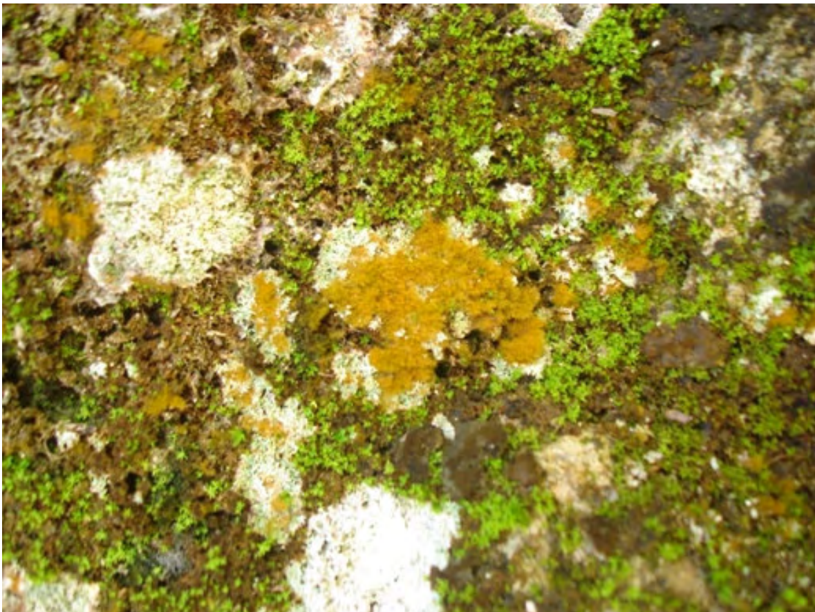
Figura 26. Cobertura de organismos vegetales menores, presencia de algas, briófitas y líquenes. Bloque calizo Edificio 134 Yaxha (Foto D. Aquino).
